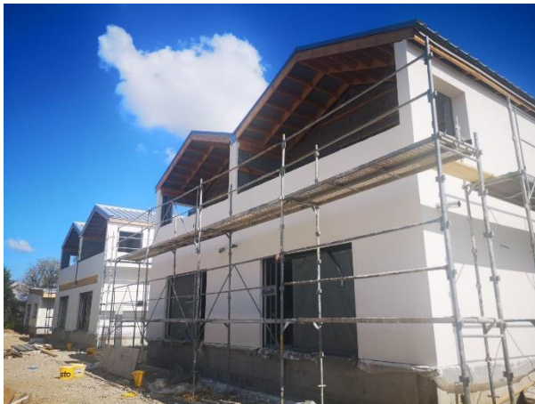
Vue des maisons en phase DET
