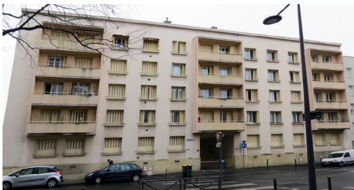
Vue sur la Résidence DESCARTES
