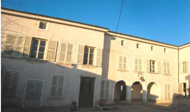
Vue du bâtiment existant depuis la cour
