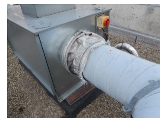
Photos des groupes de ventilation en toiture : état normal
